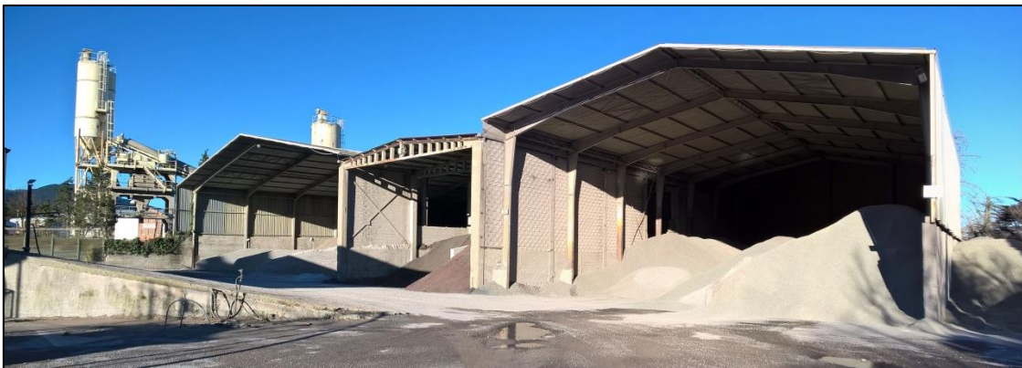
Acopios de áridos y residuos de asfalto.
