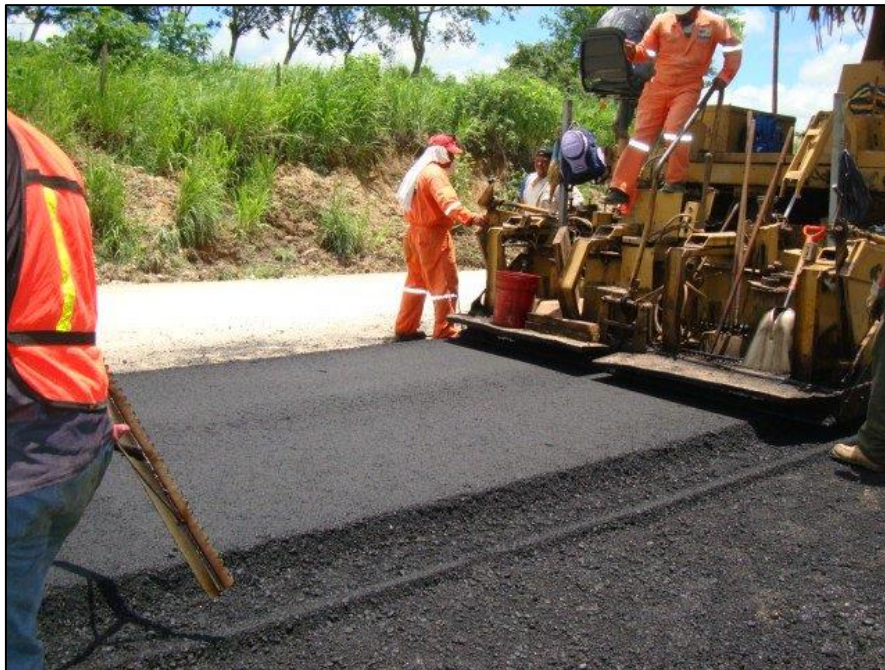
Colocación en obra de aglomerado asfáltico.
